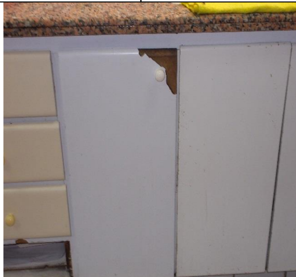
Deterioro por humedad
