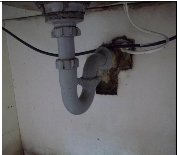
Goteo de agua residual
