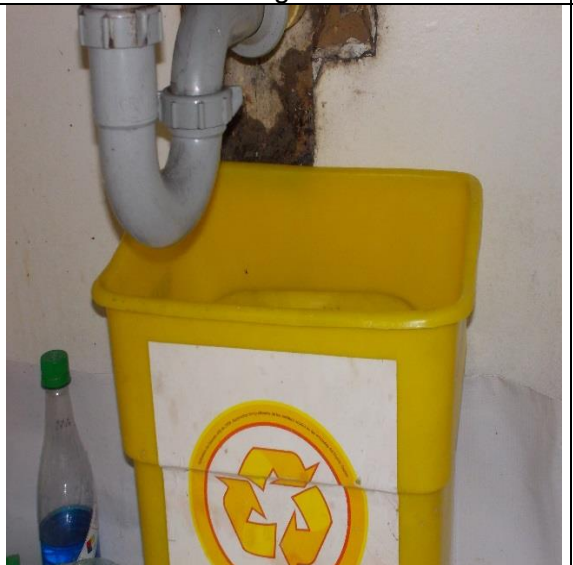
Goteo de agua residual
